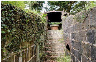
階段を登った先に装甲掩蓋がある
